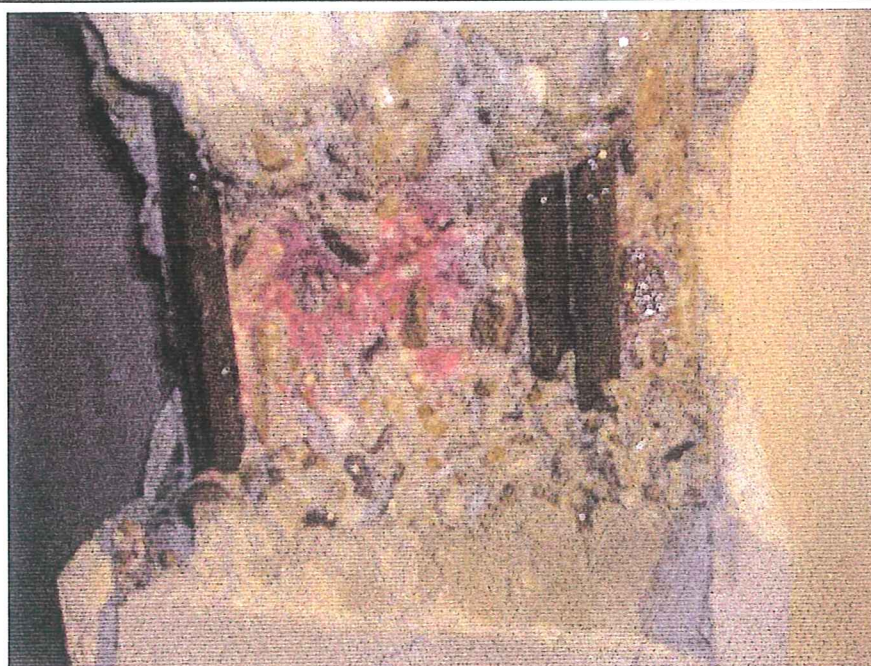
6- Armadura de viga y grado de carbonatación del hormigón.
