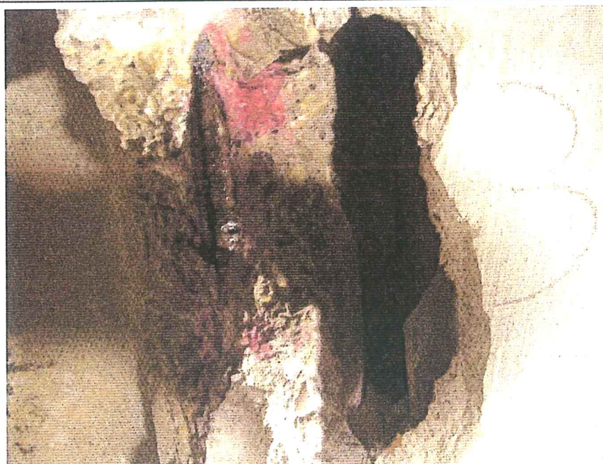
8- Detalle armadura de vigueta y grado de carbonatación del hormigón.
