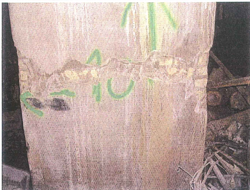
1- Roza en muro de fábrica de ladrillo
