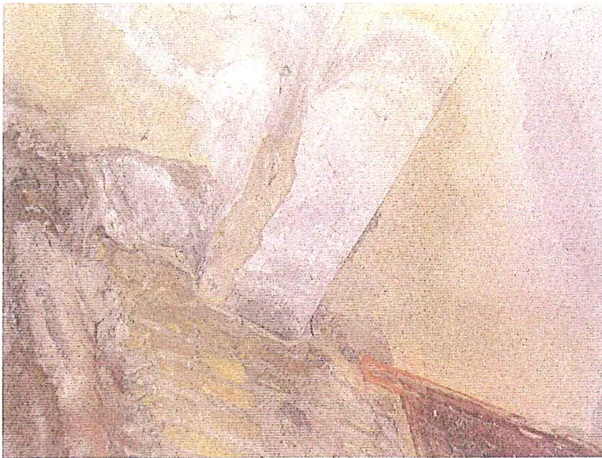
3- Detalle apoyo de vigüeta sobre muro de fábrica de ladrillo.
