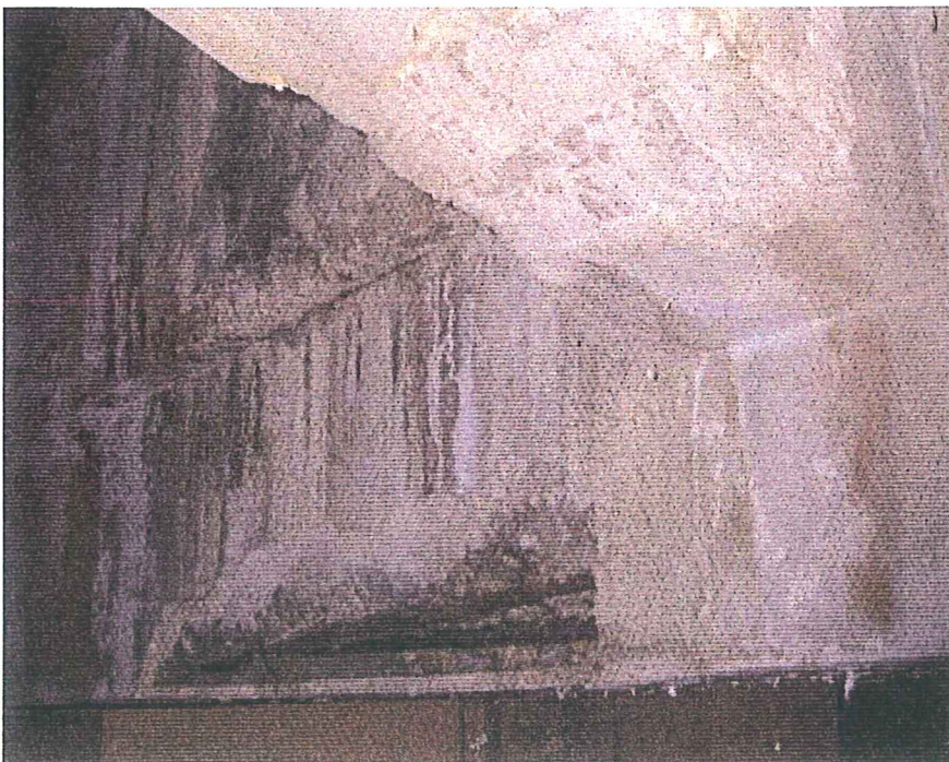
4- Pérdida de recubrimiento por corrosión de armadura.
