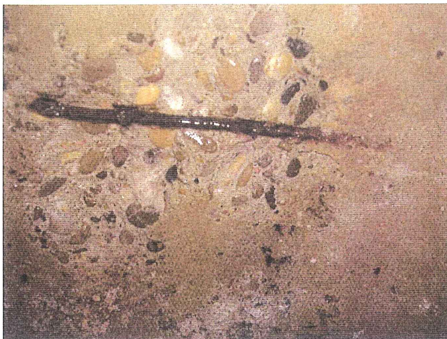
9- Detalle armadura capa compresión y grado de carbonatación del hormigón.
